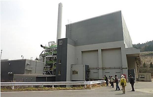
廃木材・剪定枝などの木質チップを燃料とする発電所で、バイオマス発電としては大規模であり、発電出力13,600kW、およそ25,000世帯分に該当します。営業運転開始は2011年9月で、東京電
