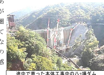
途中で寄った本体工事のハゲ場ダム
